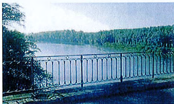
Ici le pont de la RD 52 vers Grisolles
