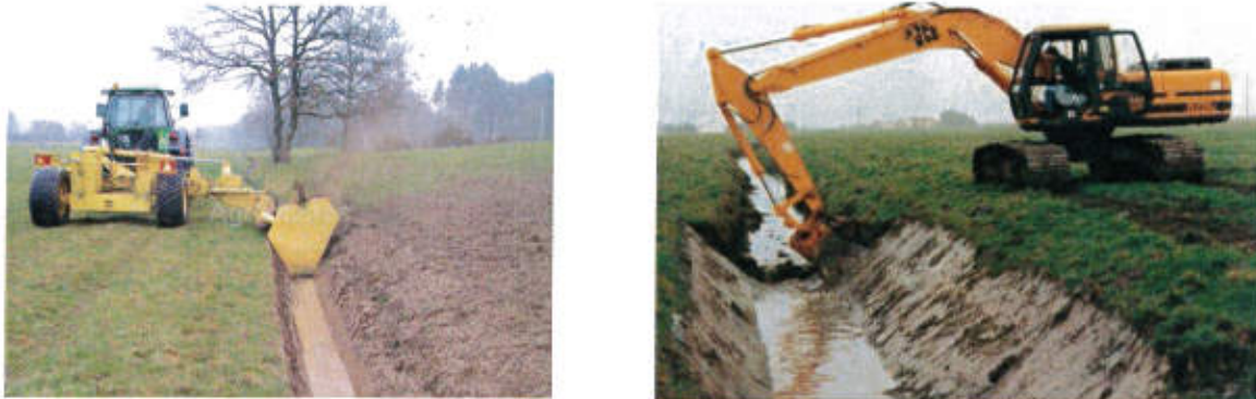
Figure 35 : Exemples de curage et reprofilage de fossés
