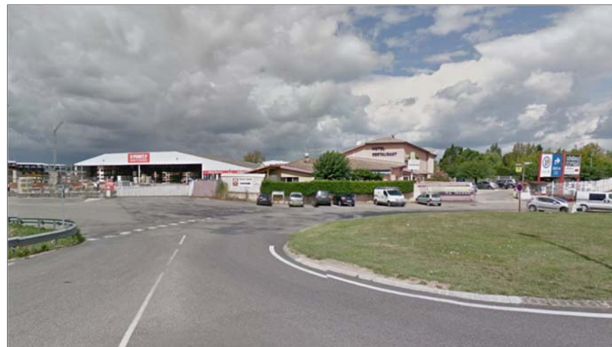
Figure 16 : Entrée de la zone Marches depuis l'échangeur de l'autoroute
